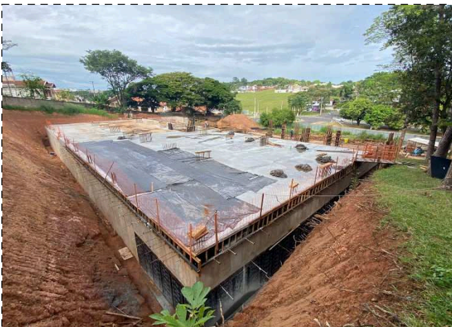
FOTO 3 – 1ª laje garagem
