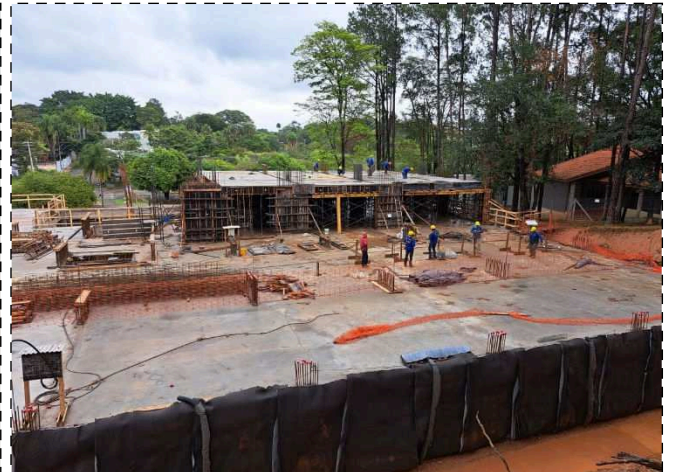
FOTO 4 – Laje garagem G1
