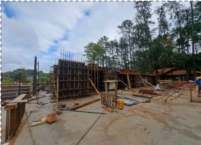
FOTO 3 – Laje garagem G1
