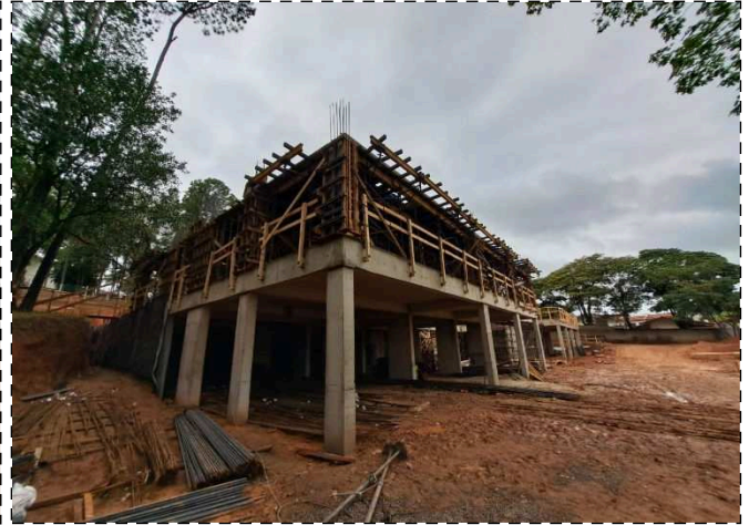
FOTO 2 – Laje garagem G1
