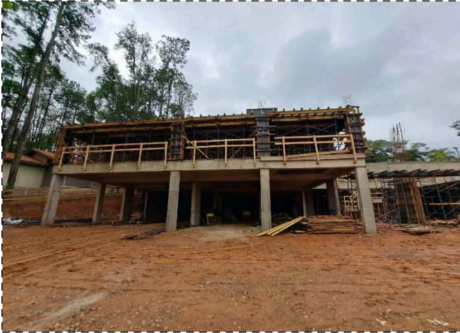
FOTO 1 – Laje garagem G1
