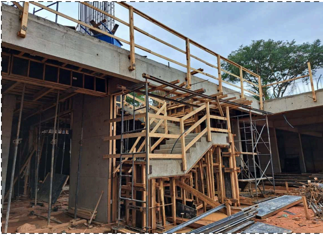
FOTO 1 – Escada Garagem G3
