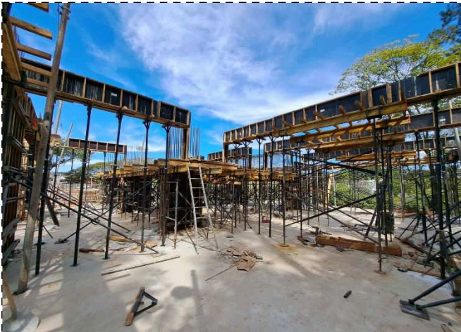
FOTO 3 – Laje garagem G1
