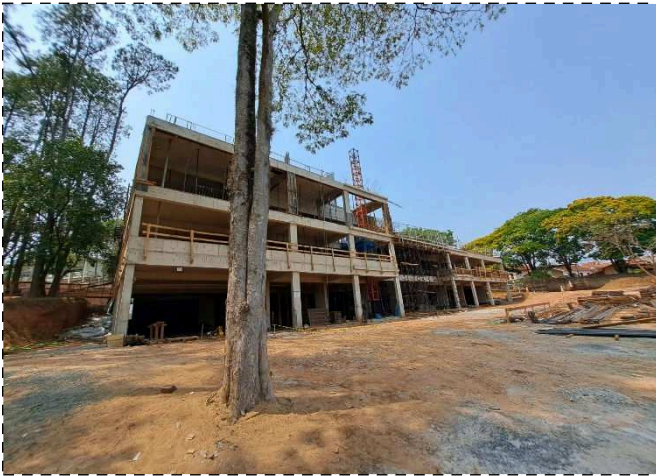
FOTO 1 – Laje garagem G1
