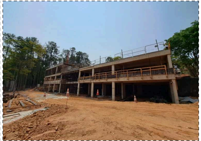
FOTO 2 – Laje garagem G1
