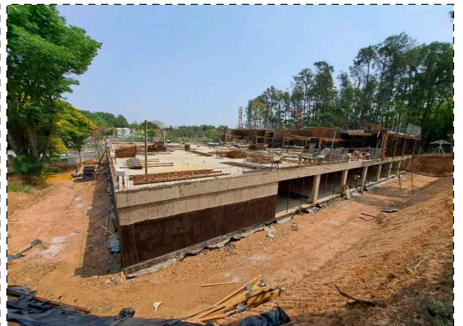
FOTO 4 – Laje garagem G1
