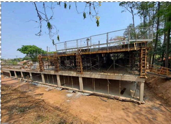
FOTO 3 – Laje garagem G1
