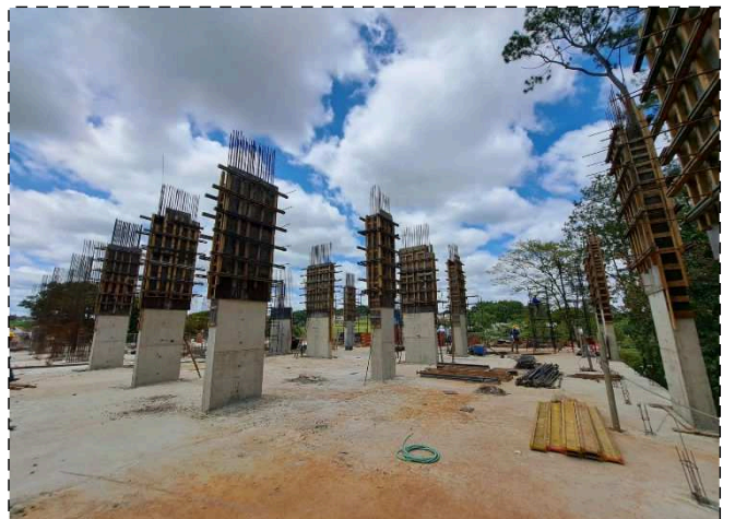
FOTO 4 – Pilares 1º pav tipo
