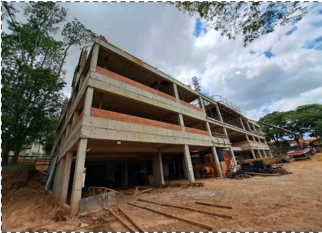
FOTO 1 – Laje garagem G1
