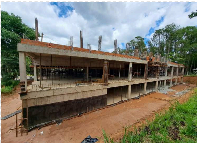
FOTO 3 – Laje garagem G1
