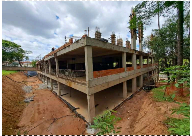
FOTO 2 – Laje garagem G1
