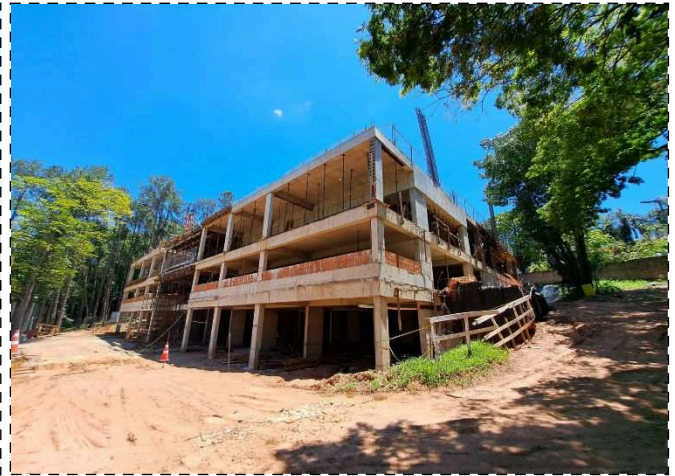
FOTO 2 – Laje garagem G1
