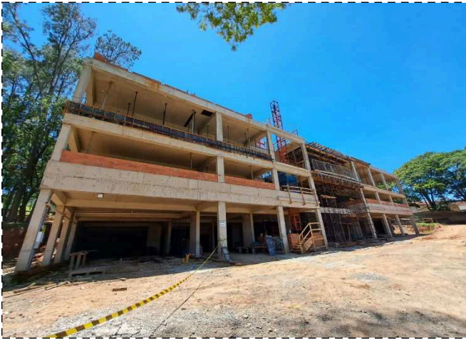
FOTO 1 – Laje garagem G1
