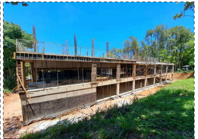
FOTO 4 – Laje garagem G1
