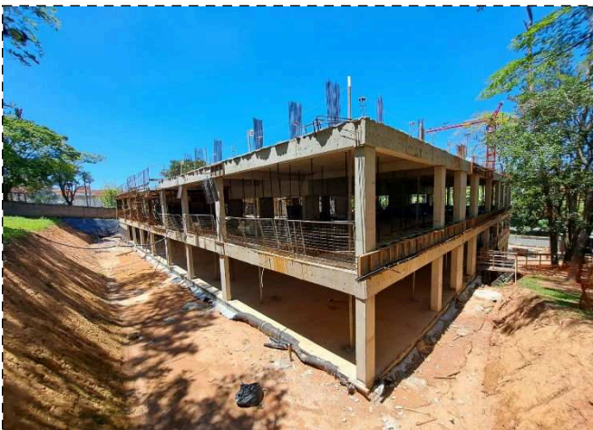
FOTO 3 – Laje garagem G1
