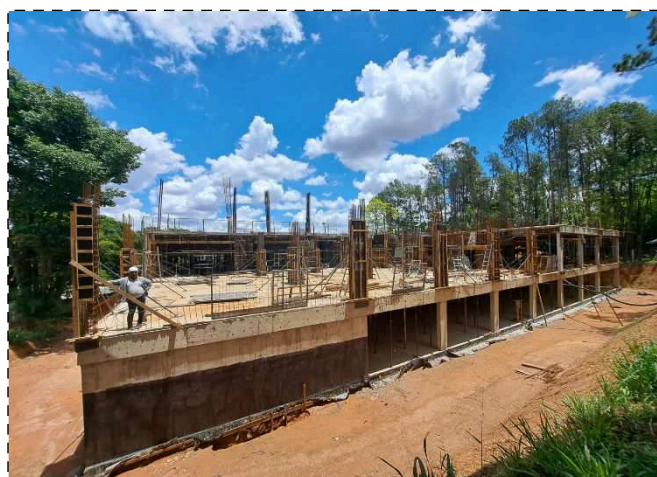
FOTO 4 – Laje garagem G1
