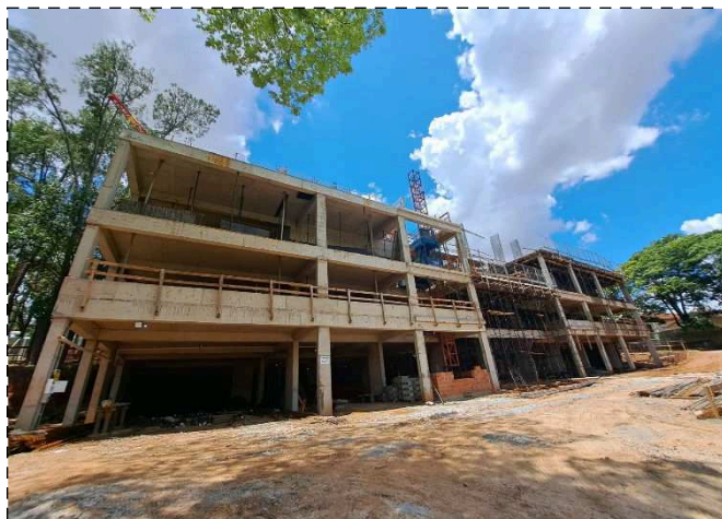
FOTO 1 – Laje garagem G1
