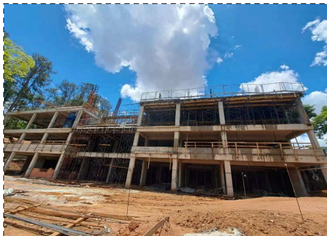
FOTO 2 – Laje garagem G1
