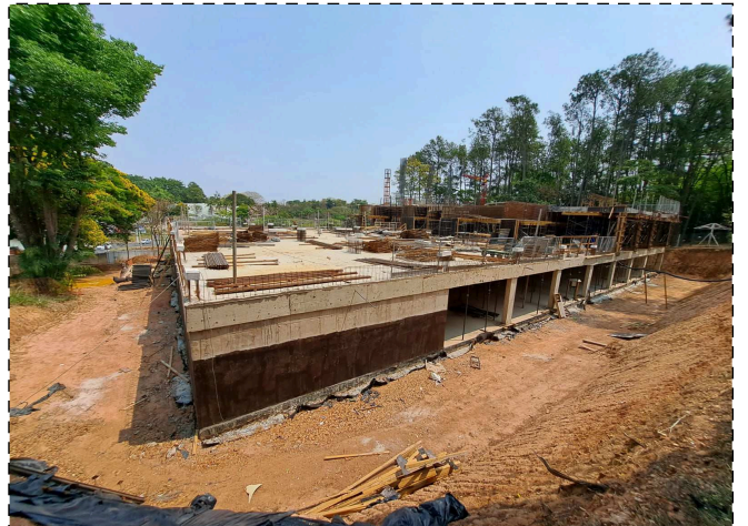
FOTO 4 – Laje garagem G1
