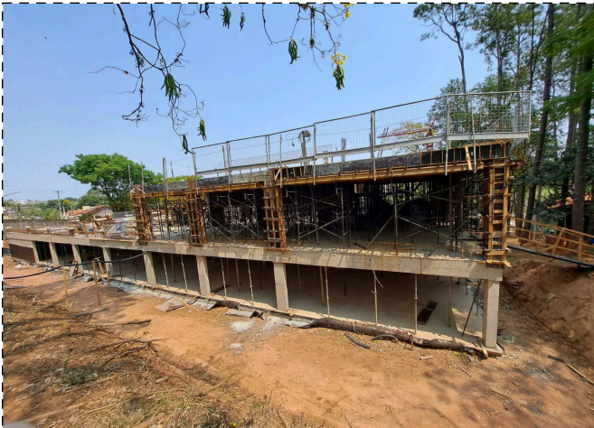
FOTO 3 – Laje garagem G1
