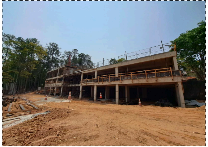
FOTO 2 – Laje garagem G1
