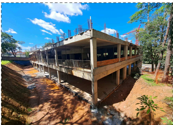
FOTO 3 – Laje garagem G1
