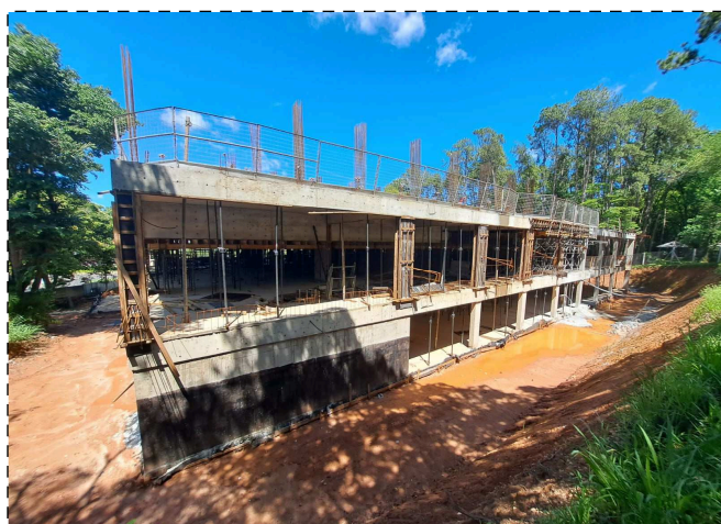
FOTO 4 – Laje garagem G1
