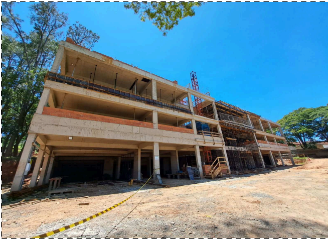
FOTO 1 – Laje garagem G1
