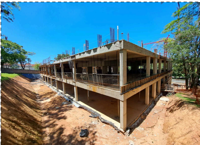
FOTO 3 – Laje garagem G1
