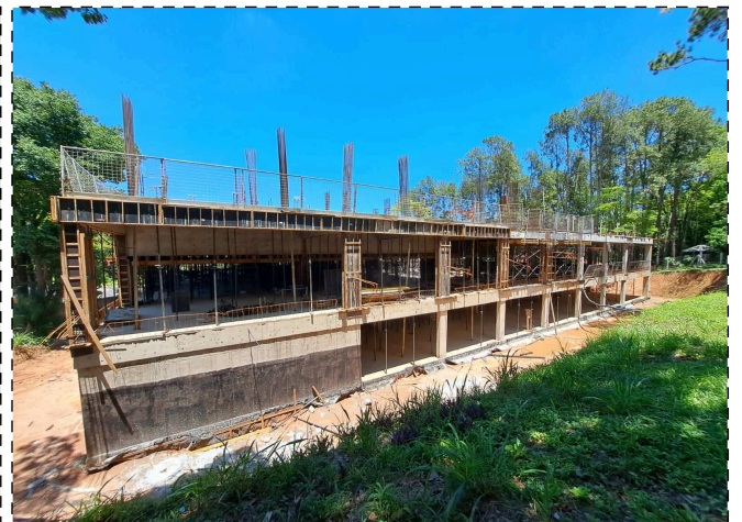
FOTO 4 – Laje garagem G1
