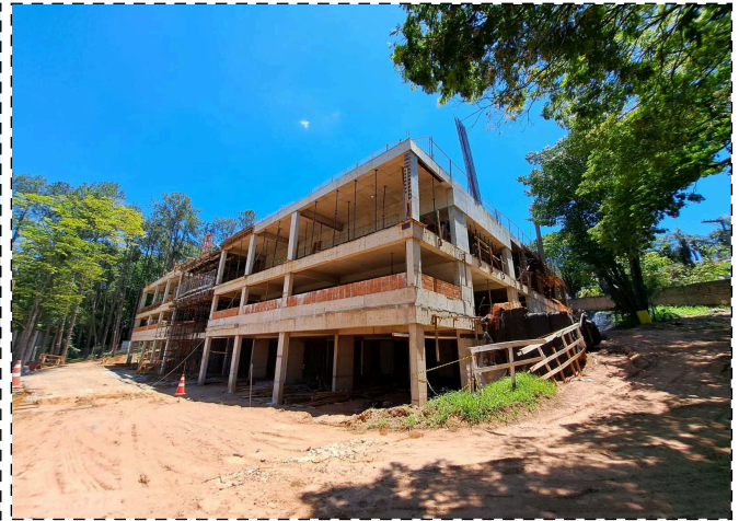
FOTO 2 – Laje garagem G1
