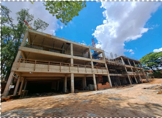
FOTO 1 – Laje garagem G1
