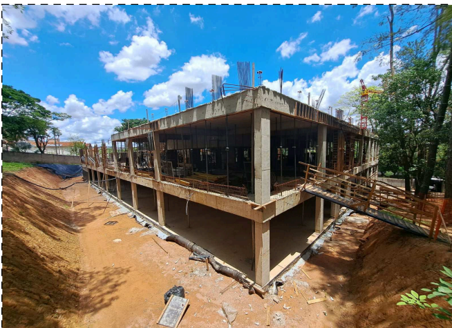
FOTO 3 – Laje garagem G1
