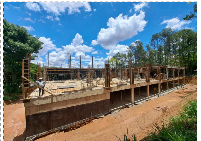
FOTO 4 – Laje garagem G1
