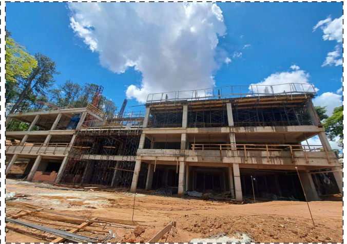
FOTO 2 – Laje garagem G1
