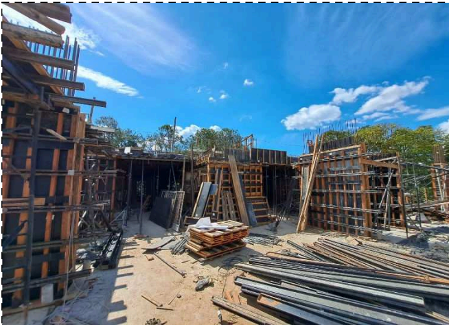
FOTO 3 – Estrutura 1º pavimento
