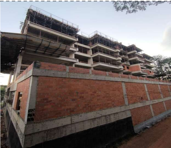
FOTO 3 – Alvenaria da Garagens
