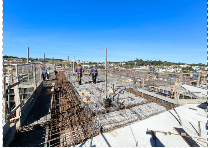
FOTO 2 – Laje do 4º PAV
