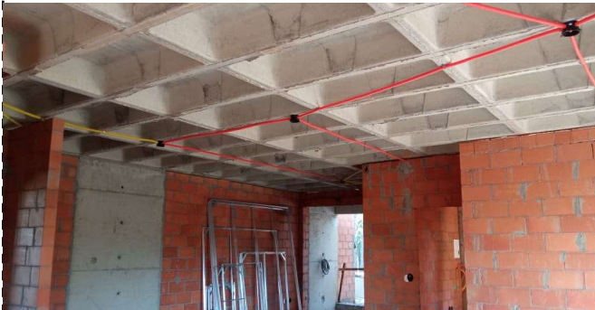
FOTO 3 – Início Das Caxinhas elétricas Teto+Parede
