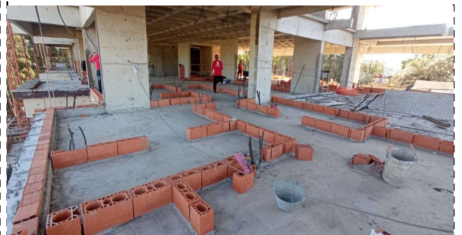
FOTO 4 – Início da Marcação alvenaria 1º Pav
