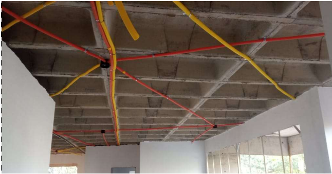
FOTO 3 – Início Das Caxinhas elétricas Teto+Parede
