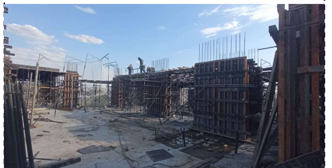
FOTO 6 – Montagem da Laje do 7º pav Techo B
