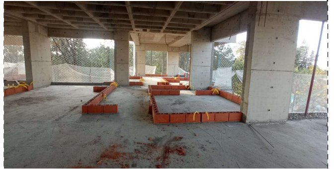
FOTO 4 – Início da Marcação alvenaria 3º Pav
