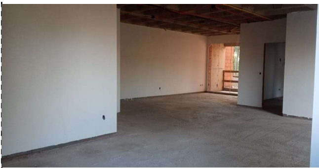
FOTO 5 – Aplicação de Gesso liso
