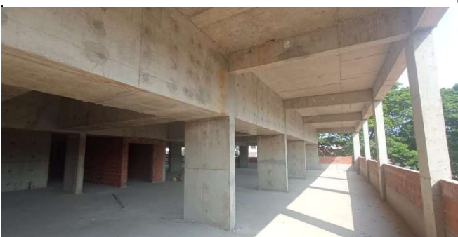
FOTO 6 – Tratamento da Estrutura nos Pavimentos de Estacionamento
