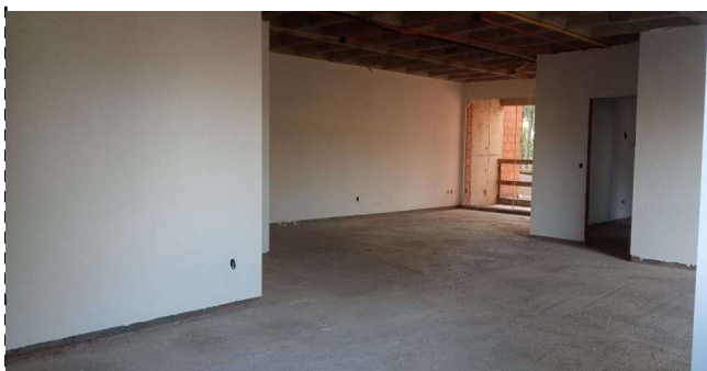
FOTO 5 – Aplicação de Gesso liso
