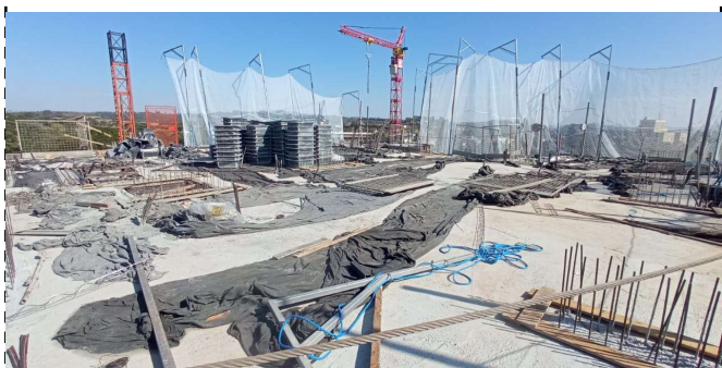
FOTO 5 – Laje do 9.A pavimento
