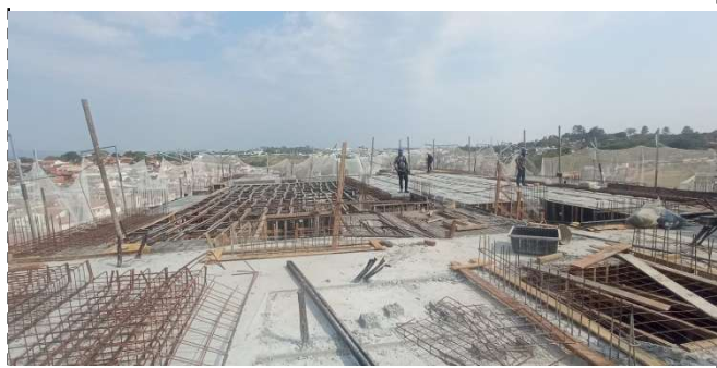
FOTO 6 – Laje do 9.B pavimento
