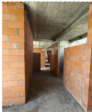
FOTO 6 – Execução e Alvenaria 6º Pav
