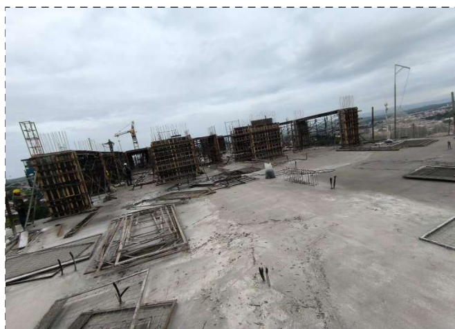
FOTO 4 – Pilares do 15º pav
