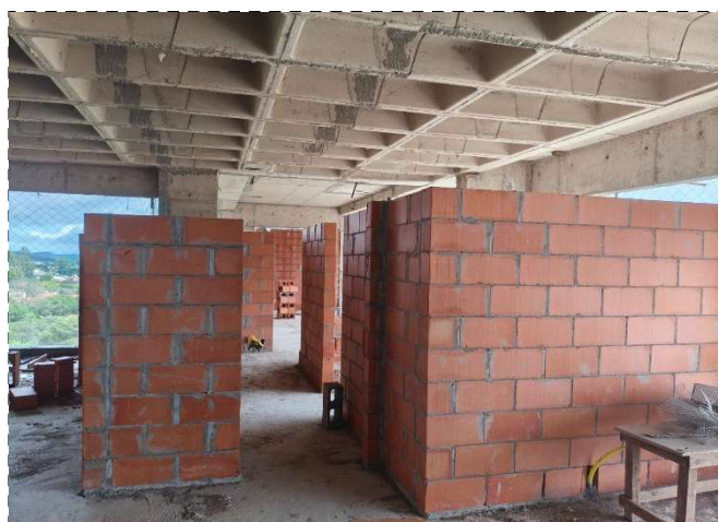
FOTO 6 – Alvenaria do 11º Pav (7º pav Tipo)
