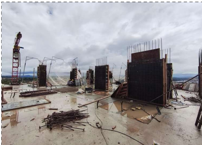
FOTO 3 – Montagem dos Pilares da 15ª Laje
