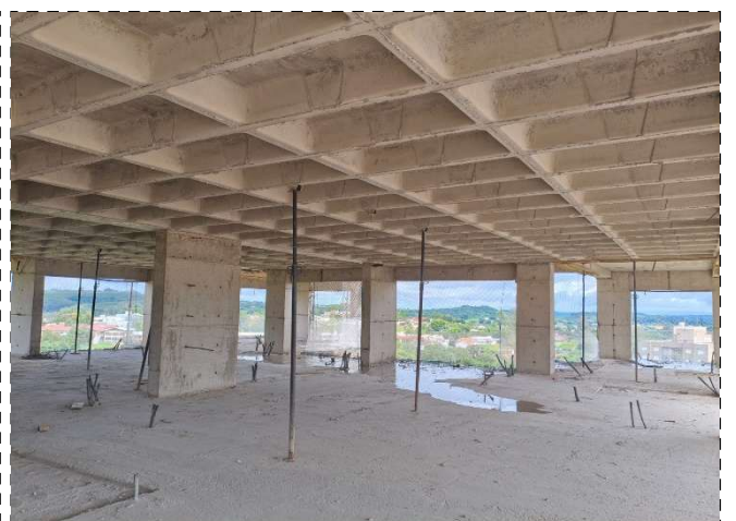
FOTO 6 – Limpeza da Laje do 8º Pav
