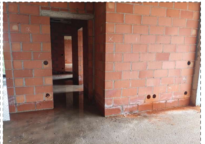
FOTO 4 – Furação de Infra Elétrica
