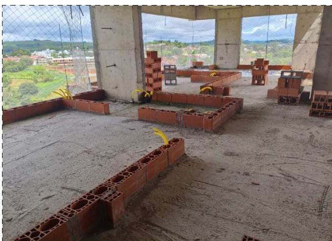
FOTO 5 – Marcação da Alvenaria do 7º Pav
