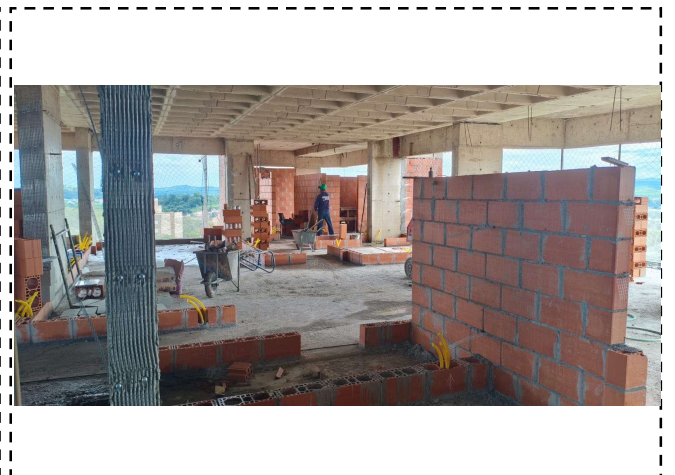
FOTO 6 – Alvenaria do 12º Pav (8º pav Tipo)
