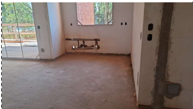
FOTO 3 – Distribuição de esgoto e água fria das cozinhas e da lavanderia do 1º pavimento.
