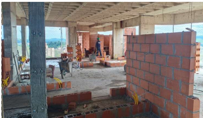
FOTO 6 – Execução da alvenaria do 10º Pav
