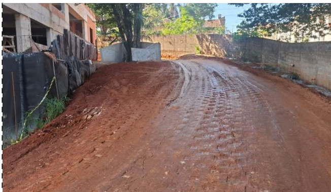
FOTO 2 – Vista da rampa de acesso aos pavimento G2 e G3
