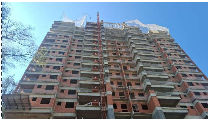
FOTO 1 – Vista Frontal da Torre
